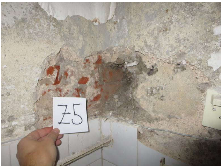
Slika 7: Preiskovalna sonda Z5 na zidu v pritličju; stik opečne in nearmirane betonske stene
