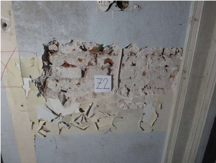
Slika 4: Preiskovalna sonda Z2 na zidu v pritličju z notranje strani; opečni zid (ni grajen iz betonskih votlakov)
