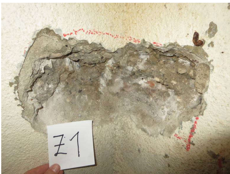
Slika 3: Preiskovalna sonda Z1 na kletni steni; nearmiran beton
