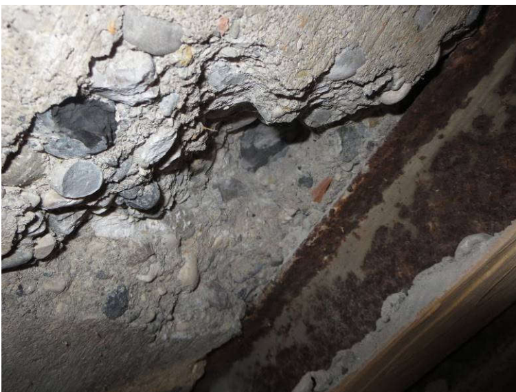
Slika 18: Preiskovalna sonda S2 na stropu nad pritličjem; nosilec izveden iz dveh jeklenih I profilov in betona; beton nad jeklenim nosilcem je nearmiran
