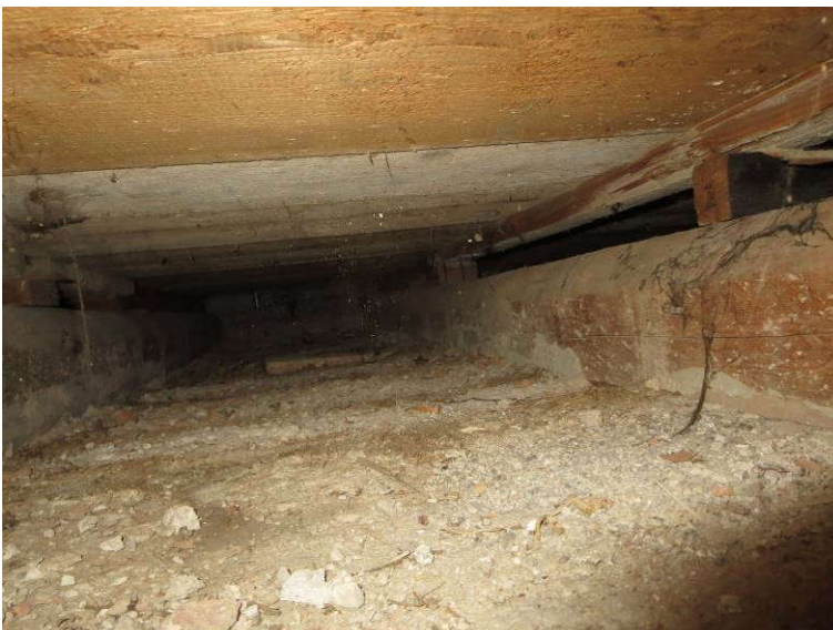
Slika 23: Preiskovalna sonda S4 na stropu nad pritličjem; nad stropniki so deske, pod stropniki pa omet na letvah; nasutje ni izvedeno
