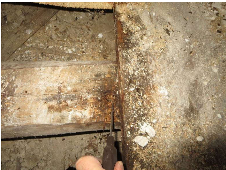
Slika 25: Preiskovalna sonda S5 na stropu nad 1. nadstropjem; odprto v območju vidnih sledov zamakanja; leseni stropni nosilec je v območju sodne lokalno poškodovan (oslabitev prereza)
