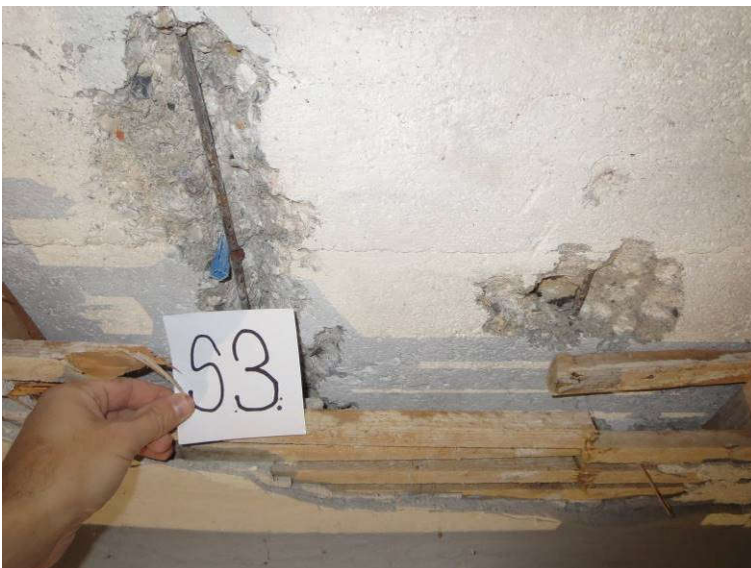
Slika 20: Preiskovalna sonda S3 na stropu nad pritličjem; betonska plošča na jeklenih profilih
