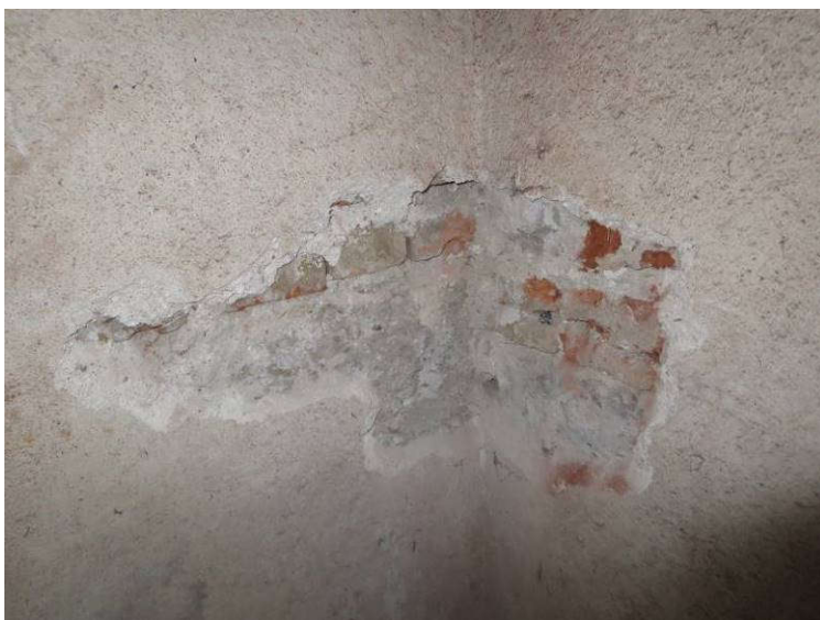
Slika 38: Preiskovalna sonda 12 na zidu v pritličju garaže; prečna stena (levo): spodaj nearmiran beton, nad njim opečni zid, vzdolžna stena (desno): spodaj kamniti zid, nad njim opečni zid s kamnitimi vložki
