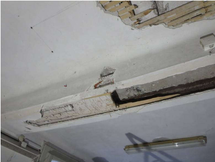
Slika 16: Preiskovalna sonda S2 na stropu nad pritličjem; nosilec izveden iz dveh jeklenih I profilov in betona
