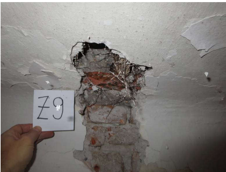
Slika 12: Preiskovalna sonda Z9 na zidu v 2. nadstropju; pod stropom ni izvedene zidne vezi
