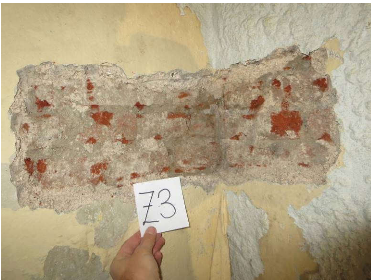
Slika 5: Preiskovalna sonda Z3 na zidu v pritličju; v vogalu je izvedena zidarska zveza s preklopi zidakov
