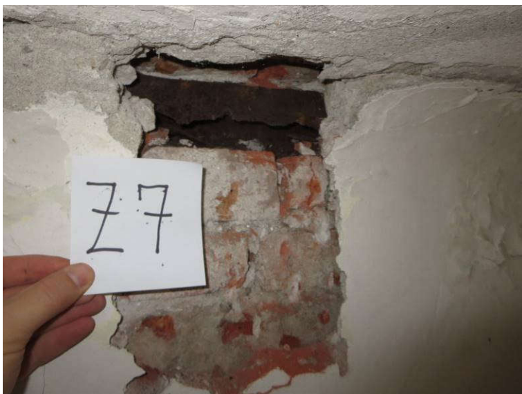
Slika 9: Preiskovalna sonda Z7 na zidu v 2. nadstropju; pod stropom je vgrajena jeklena vez iz zvrnjenega I profila; prisotna močna korozija I profila
