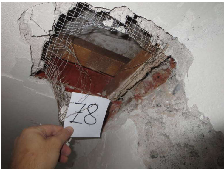
Slika 11: Preiskovalna sonda Z8 na zidu v 2. nadstropju; pod stropom je izveden betonski nosilec; zgoraj betonski strop na jeklenih nosilcih
