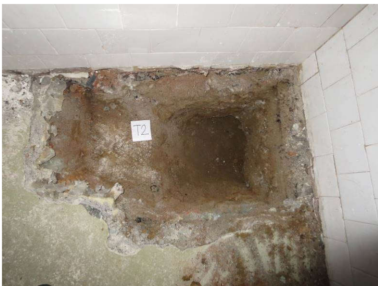
Slika 2: Sondažni izkop T2 ob temelju v pritličju;
