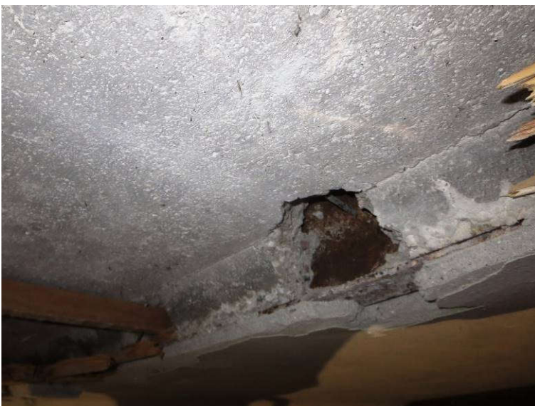
Slika 21: Preiskovalna sonda S3 na stropu nad pritličjem; betonska plošča na jeklenih profilih; armaturne palice plošče se ne nadaljujejo skozi jekleni nosilec
