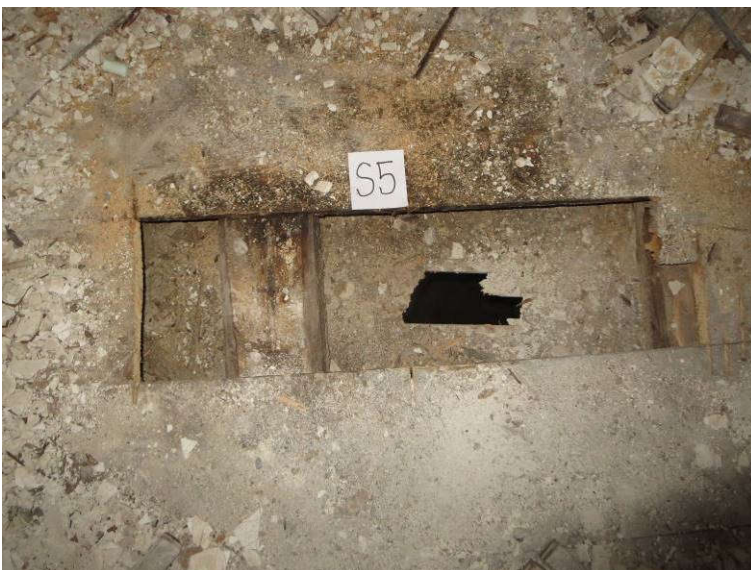
Slika 24: Preiskovalna sonda S5 na stropu nad 1. nadstropjem; odprto v območju vidnih sledov zamakanja (pod mestom sonde S6); lesen strop
