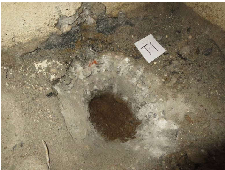
Slika 1: Sondažni izkop T1 ob temelju v kleti; na mestu sonde je izvedena temeljna plošča
