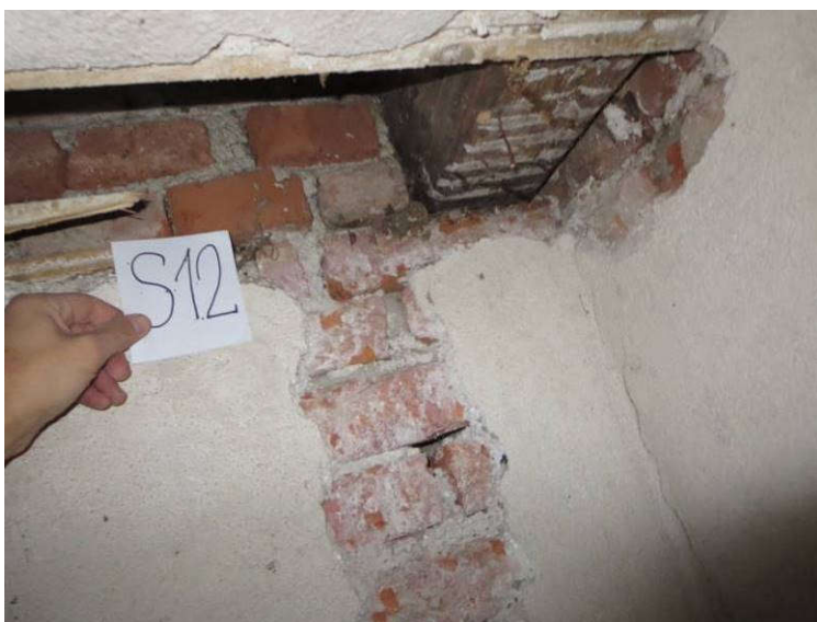
Slika 39: Preiskovalna sonda S12 na stropu nad pritličjem garaže; lesen strop; pod stropom ni izvedene zidne vezi
