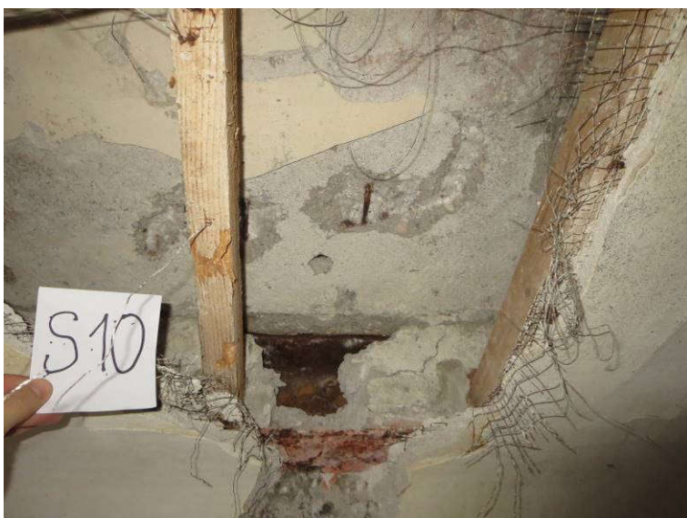
Slika 35: Preiskovalna sonda S10 na stropu nad 2. nadstropjem; betonska plošča na jeklenih profilih;
