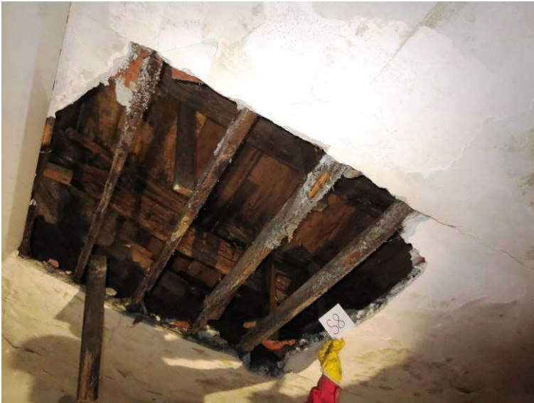
Slika 31: Preiskovalna sonda S8 na stropu nad 2. nadstropjem (streha); odprto na mestu vidnih sledov zamakanja na stropni oblogi
