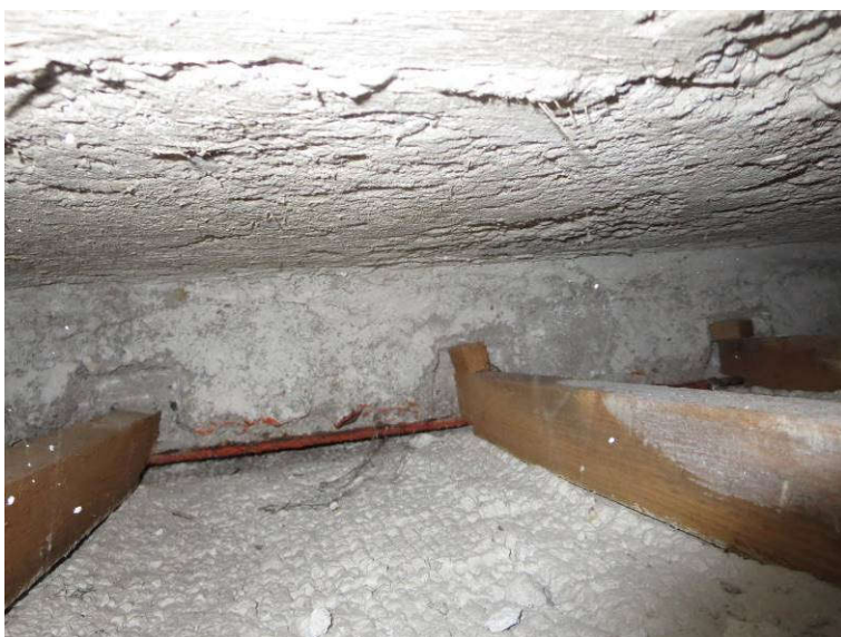
Slika 30: Preiskovalna sonda S7 na stropu nad 2. nadstropjem; betonska plošča na jeklenih profilih; jekleni profili so zapolnjeni z betonom; na jeklene nosilce nalegajo leseni tramiči, na katere je izveden omet na mrežici
