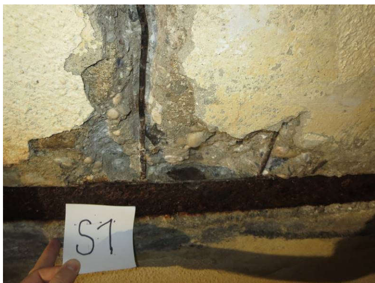
Slika 15: Preiskovalna sonda S1 na stropu nad kletjo; betonska plošča z jeklenimi profili; korozija jeklenih elementov
