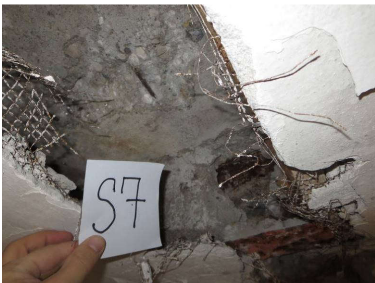
Slika 29: Preiskovalna sonda S7 na stropu nad 2. nadstropjem; betonska plošča na jeklenih profilih
