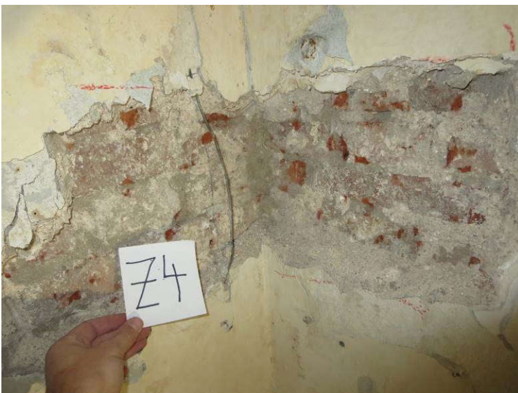
Slika 6: Preiskovalna sonda Z4 na zidu v pritličju; v vogalu je izvedena zidarska zveza s preklopi zidakov
