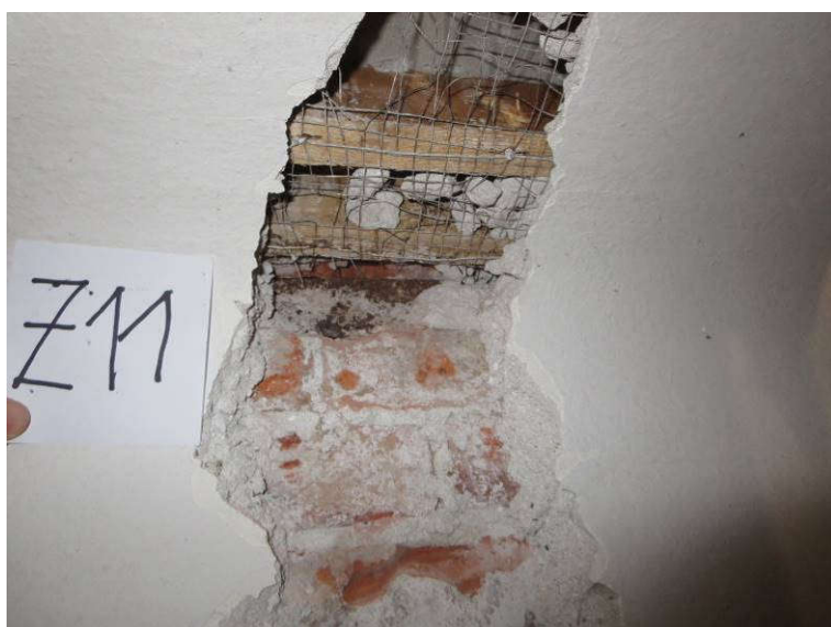
Slika 14: Preiskovalna sonda Z11 na zidu v 1. nadstropju; pod stropom je vgrajena jeklena vez iz zvrnjenega I profila
