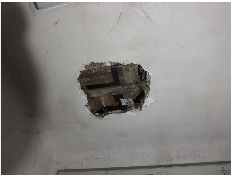
Slika 33: Preiskovalna sonda S9 na stropu nad 2. nadstropjem (streha); odprto na mestu brez vidnih sledov zamakanja na stropni oblogi
