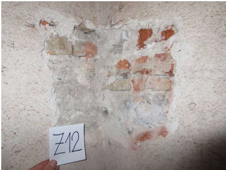
Slika 37: Preiskovalna sonda 12 na zidu v pritličju garaže; prečna stena (levo): spodaj nearmiran beton, nad njim opečni zid, vzdolžna stena (desno): spodaj kamniti zid, nad njim opečni zid s kamnitimi vložki
