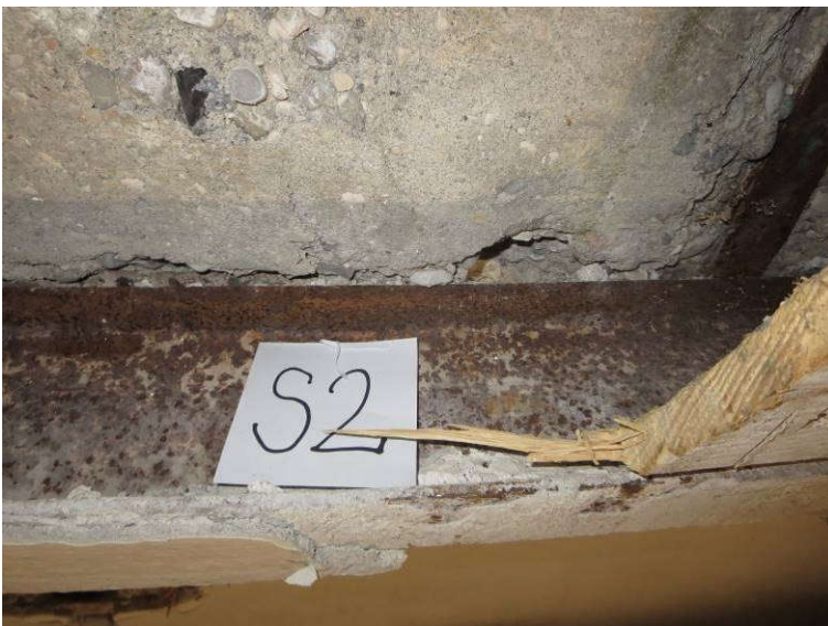
Slika 17: Preiskovalna sonda S2 na stropu nad pritličjem; nosilec izveden iz dveh jeklenih I profilov in betona; vidna prečna povezava jeklenih nosilcev;
