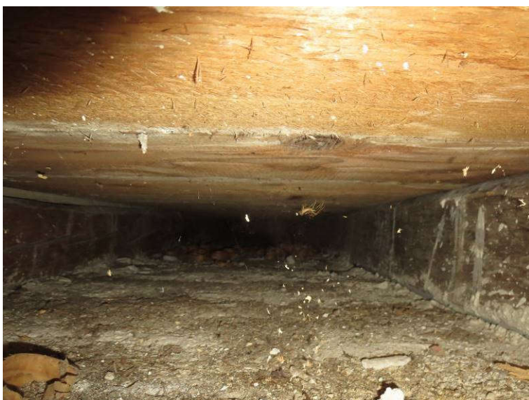
Slika 26: Preiskovalna sonda S5 na stropu nad 1. nadstropjem; nad stropniki so deske, pod stropniki pa omet na letvah; nasutje ni izvedeno
