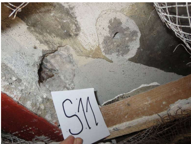
Slika 36: Preiskovalna sonda S11 na stropu nad pritličjem; betonska plošča na jeklenih profilih; spodaj leseni tramiči in omet na mrežici
