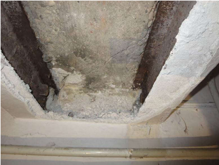
Slika 19: Preiskovalna sonda S2 na stropu nad pritličjem; nosilec izveden iz dveh jeklenih I profilov in betona; razpoka v betonu nad jeklenima nosilcema
