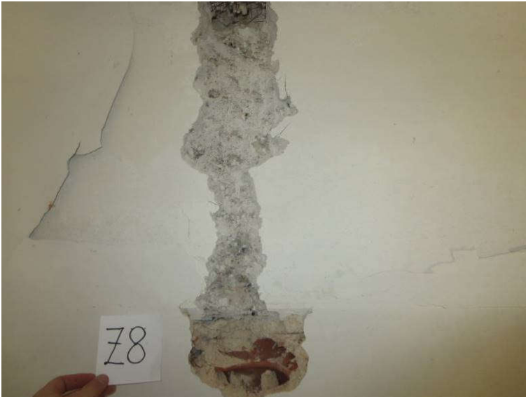
Slika 10: Preiskovalna sonda Z8 na zidu v 2. nadstropju; pod stropom je izveden betonski nosilec
