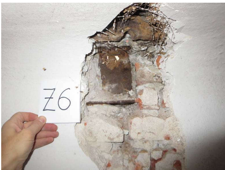
Slika 8: Preiskovalna sonda Z6 na zidu v 2. nadstropju; pod stropom je vgrajena jeklena vez iz I profila, ki pa ne poteka po celi dolžini stene – na mestu sonde viden konec profila
