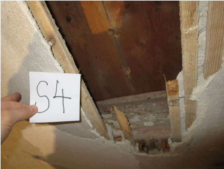
Slika 22: Preiskovalna sonda S4 na stropu nad pritličjem; lesen strop; omet na letvah
