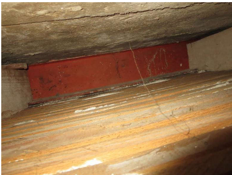
Slika 28: Preiskovalna sonda S6 na stropu nad 2. nadstropjem; betonska plošča na jeklenih profilih; spodaj leseni tramiči in letve za omet
